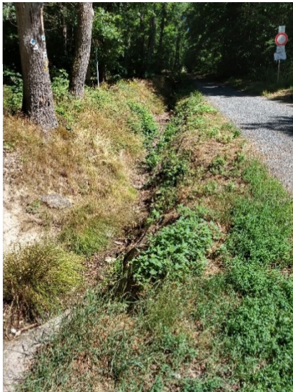
Abbildung 2: Entwässerungsgraben im Wald im Taunus (Foto: BUND)
