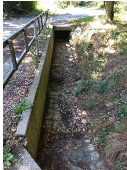
Abbildung 3: Entwässerungsbauwerk im Wald im Taunus (Foto: BUND)
