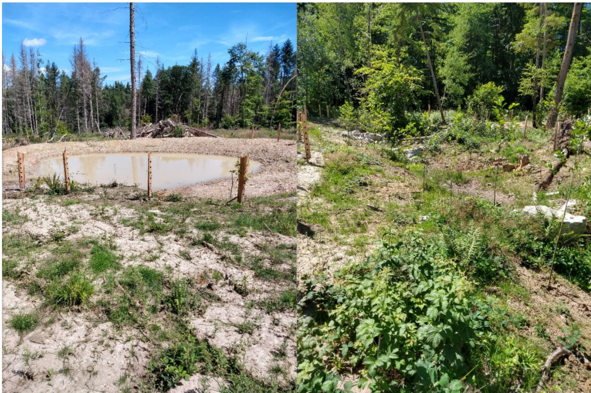
Abbildung 13: Retentions- und Versickerungsmulden Oberhain (Foto: BUND)
